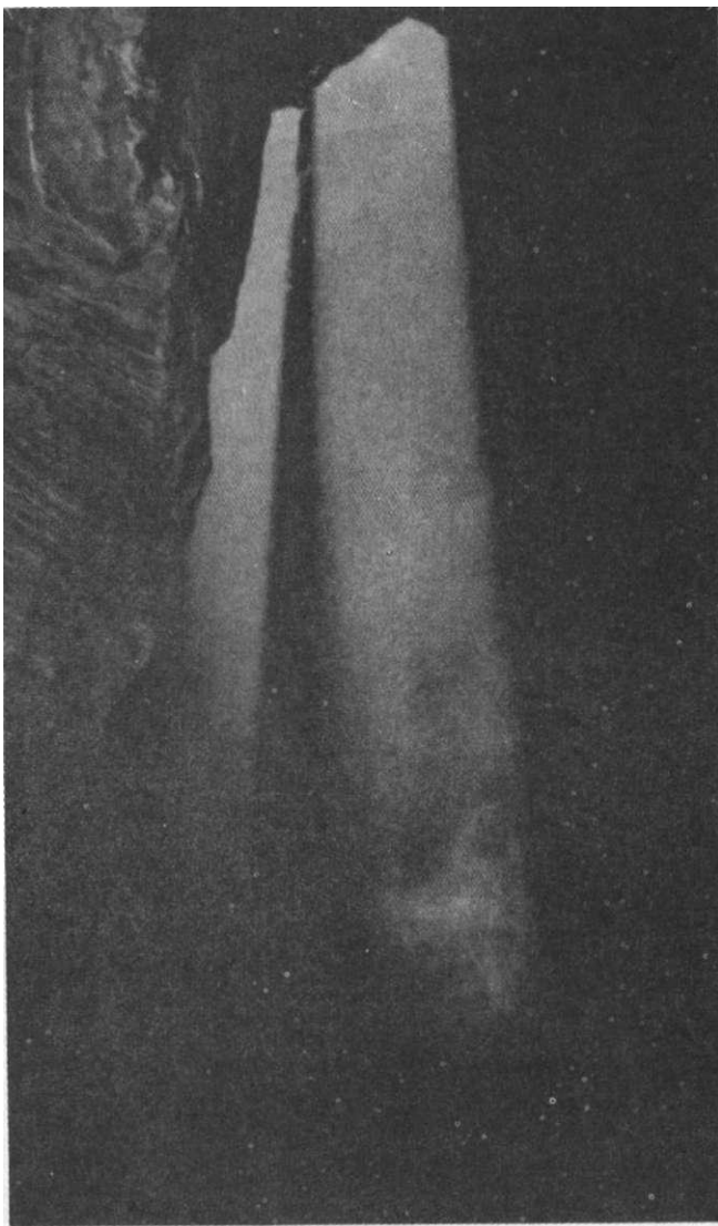
FIG. 21. Cada 1.100 m. se encuentran estos pozos de ventilación artificiales. Miden entre 1,80 y 3,10 m. de largo por 80 cm. de ancho.
